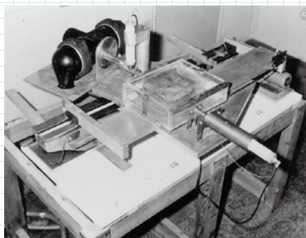
図1 G.W. HounsfieldによるCT開発時の実験装置
