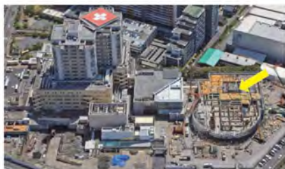
図1 湘南鎌倉総合病院と当センターの概要 湘南鎌倉総合病院は658床の許可病床を持つ総合病院である。がん放射線治療を行う施設は先端医療センターとして病院に併設され(黄色の矢印)、2021年2月末に施設の引き渡しが予定されている。
